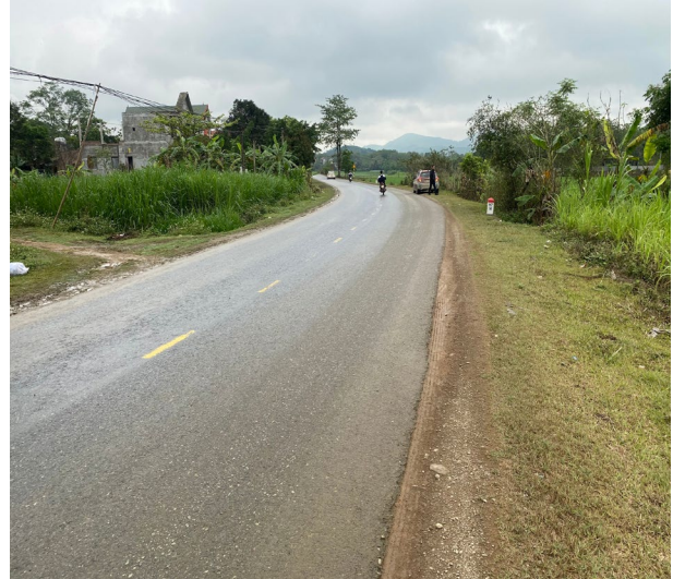
Hình 1.4. Hiện trạng tuyến Hồ Chí Minh đoạn qua gần khu vực dự án
