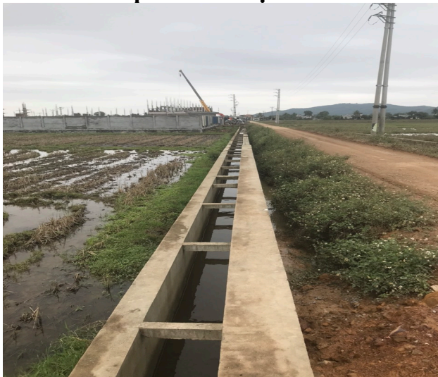
Hình 1.5. Hiện trạng tuyến mương phía Nam dự án
